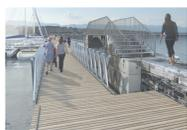
Les terrasses et avancées sur le lac sont en platelage bois afin de s'harmoniser avec la jetée du jet d'eau déjà réalisée, et ponctuer ainsi la promenade de surfaces de détente.
